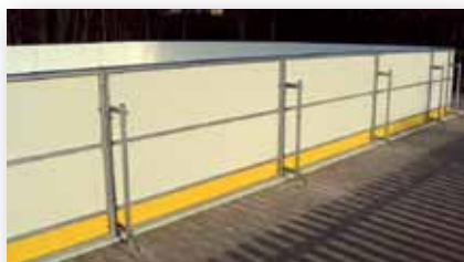
Banda AMARGO® wykonana z białych płyt polietylenowych PE 300 oraz żółtych PE 500 użytych dolnej strefie
